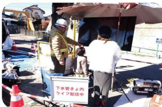
管内施工をリアルタイム公開 誰でも現地で見られる取組は全国初
